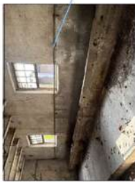
La sala per le vecchie da letto, ampliamento realizzato nel 1964 contemporaneamente alla costruzione del corpo di servizio. Il corpo di servizio è stato realizzato con i resti in cemento armato precompresso prodotti dalla ditta C.A.P. B.P.A. di Montebelluna.
