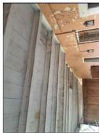
I tre edifici in cemento armato precompresso posti a cortea a seguito dell'incendio del 1961. Il edificio viene completato da diverse ali aggiunte di successi.
