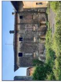
Il lato nord del corpo di fabbrica di cui al punto 1, si possono notare ancora i segni dell'incendio del 1961 (parte aerea), mentre la parte inferiore è stata ricostruita nel 1964, con l'uso di mattoni a vista.
