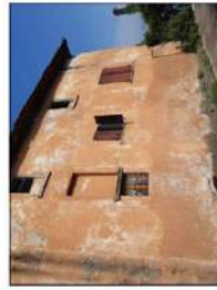
Lo stesso corpo di fabbrica in forma, rivestito e decorato nel corso degli anni '70, con l'uso di mattoni a vista e in cemento armato.
