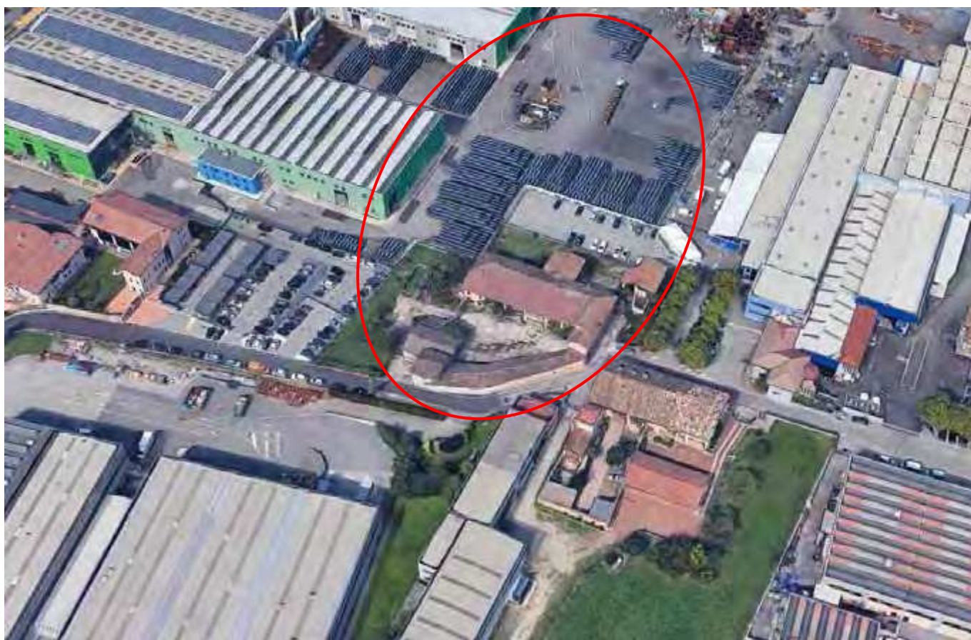
Documentazione fotografica dell'area oggetto di P.L..
