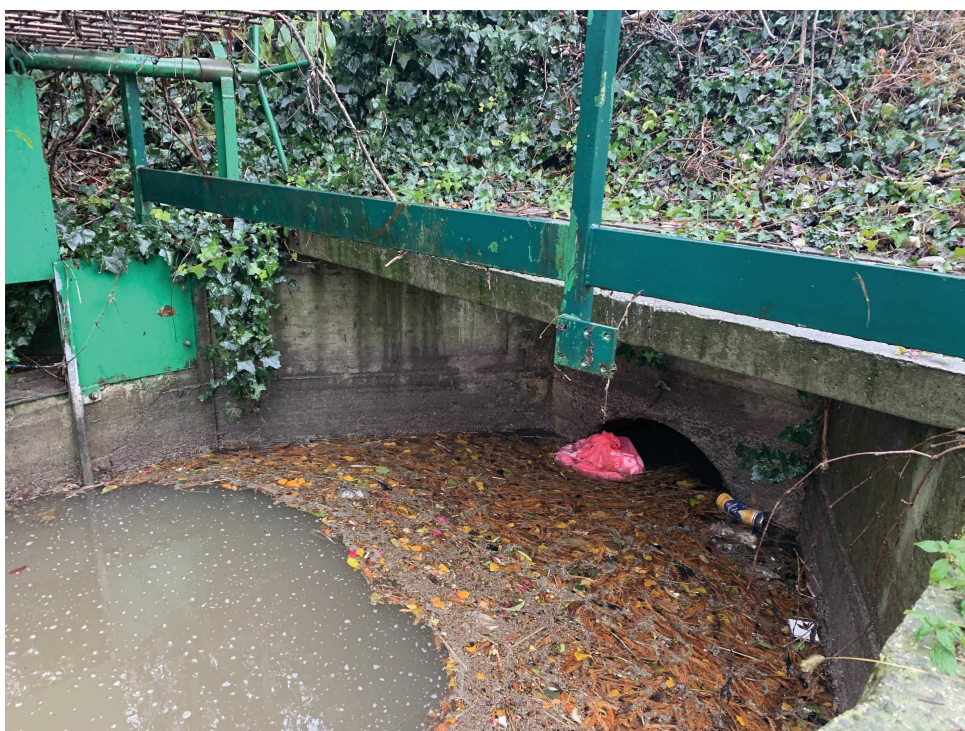
Fig.17 - Manufatto di attraversamento della ferrovia
