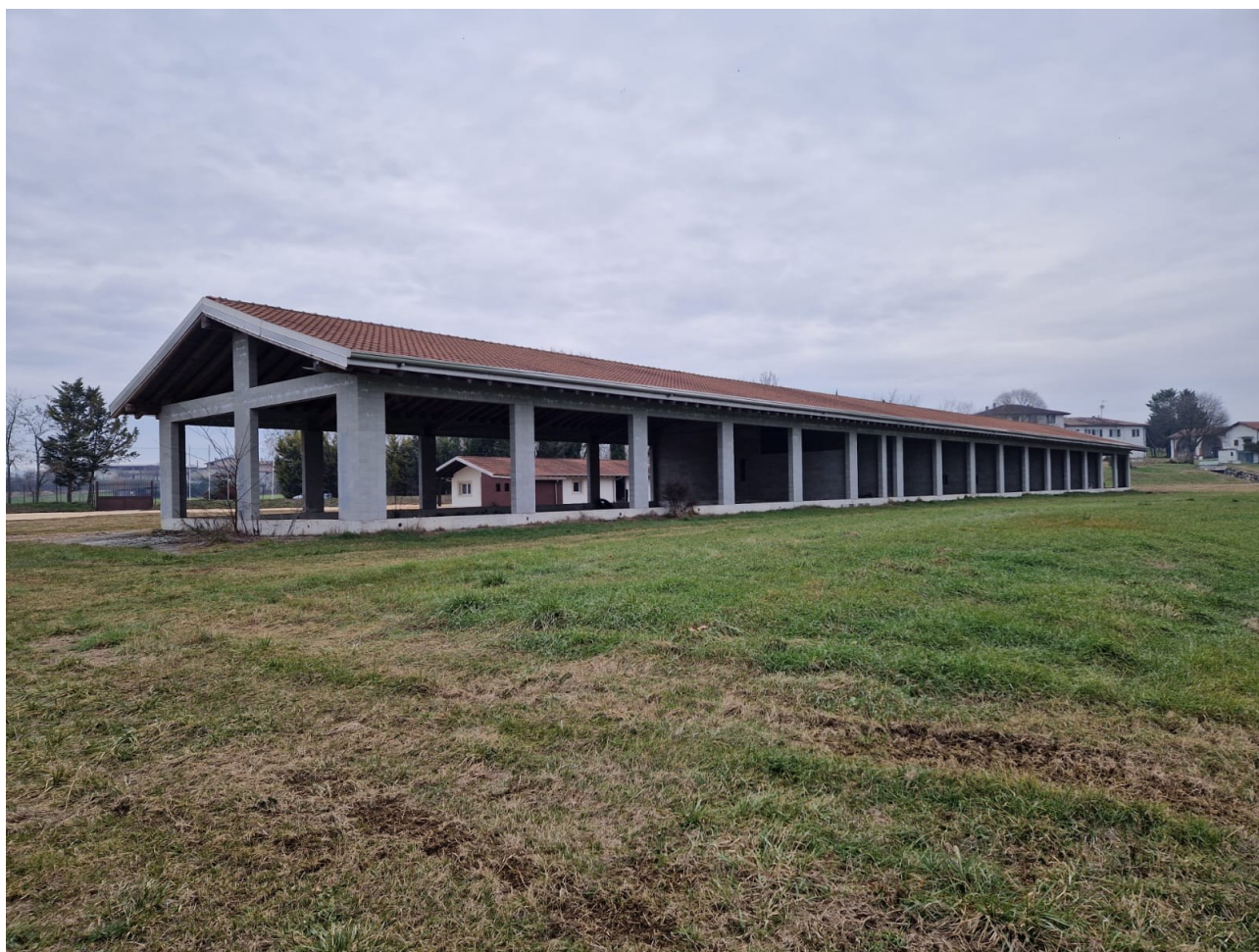
PUNTO DI PRESA 4 – Vista della scuderia da Sud-Est
