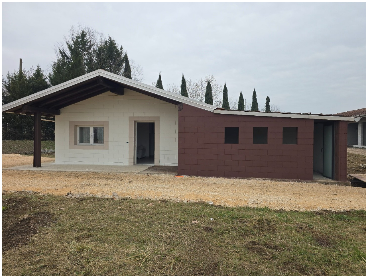
PUNTO DI PRESA 1 – Vista dell’abitazione da Ovest
