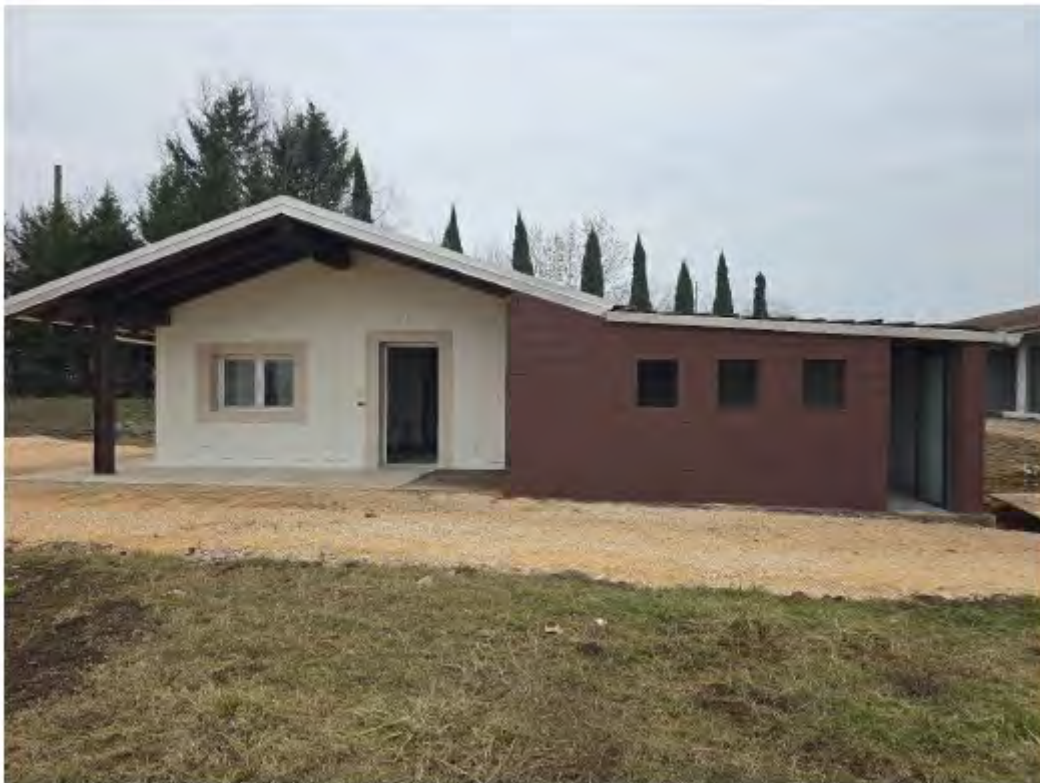
PUNTO DI PRESA 1 – Vista dell'abitazione da Ovest
