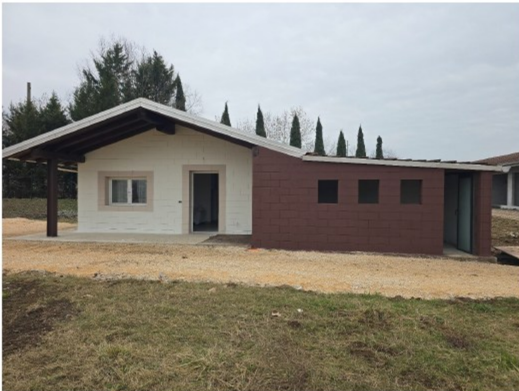
PUNTO DI PRESA 1 – Vista dell'abitazione da Ovest
