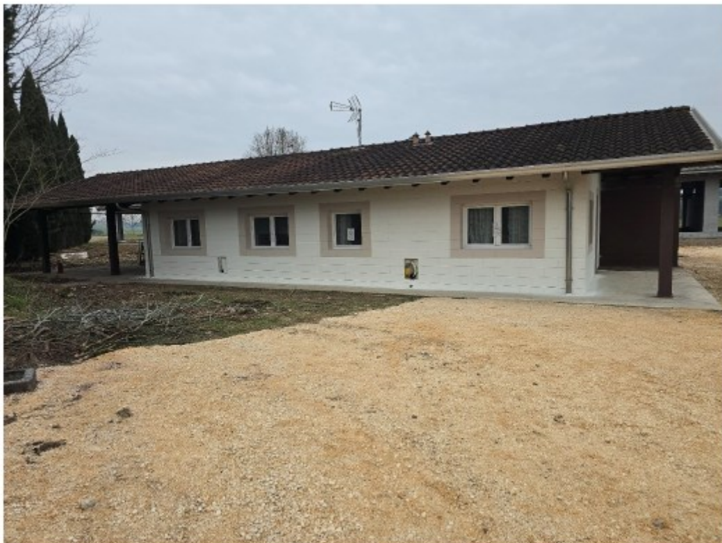
PUNTO DI PRESA 2 – Vista dell'abitazione da Nord
