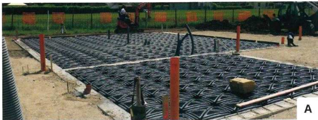
- Schema tipo di vespaio areato
