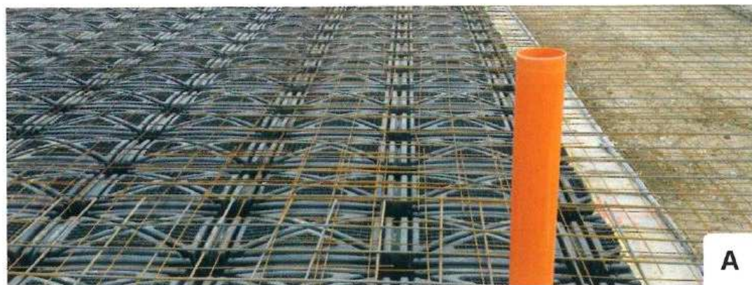
- Foto A) Foto B) Vespaio di progetto, eseguito con elementi in PVC.
