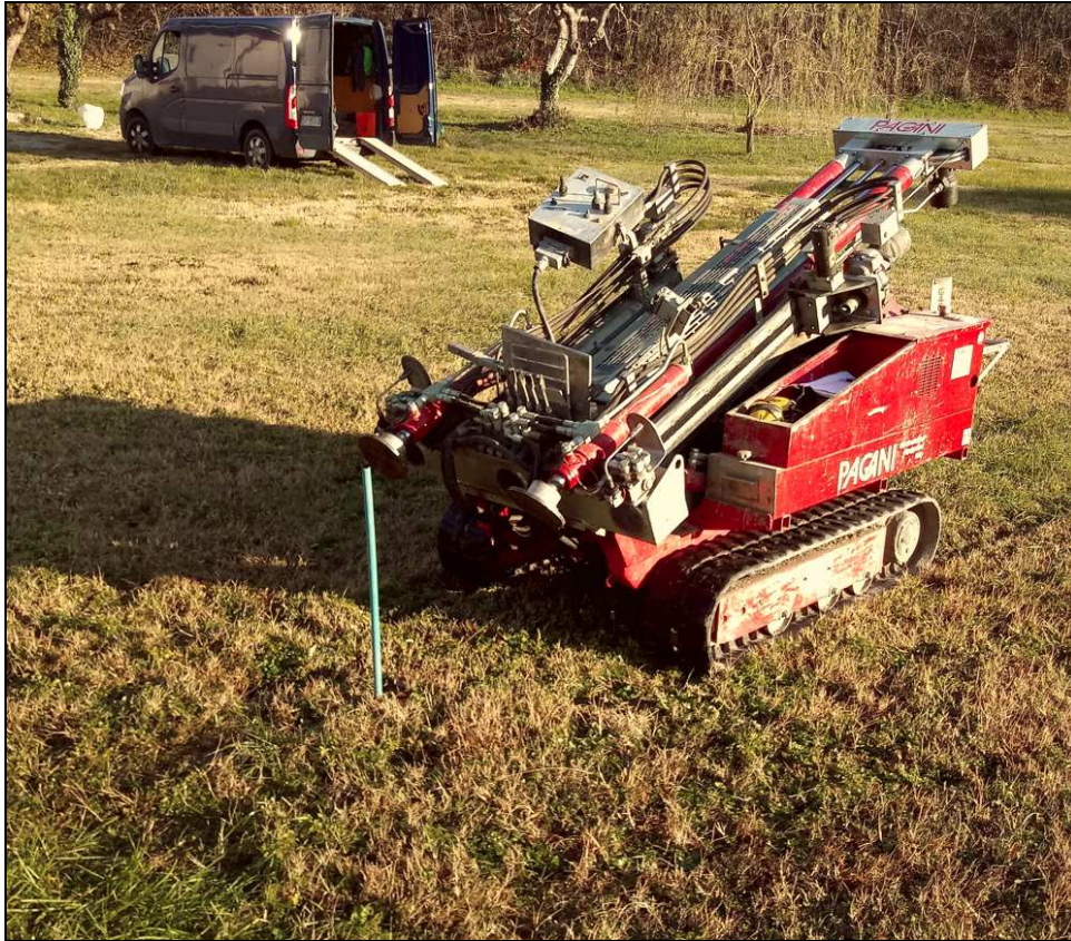
Figura 18: Installazione di tubo piezometrico temporaneo all'interno del foro della prova SCPT2
