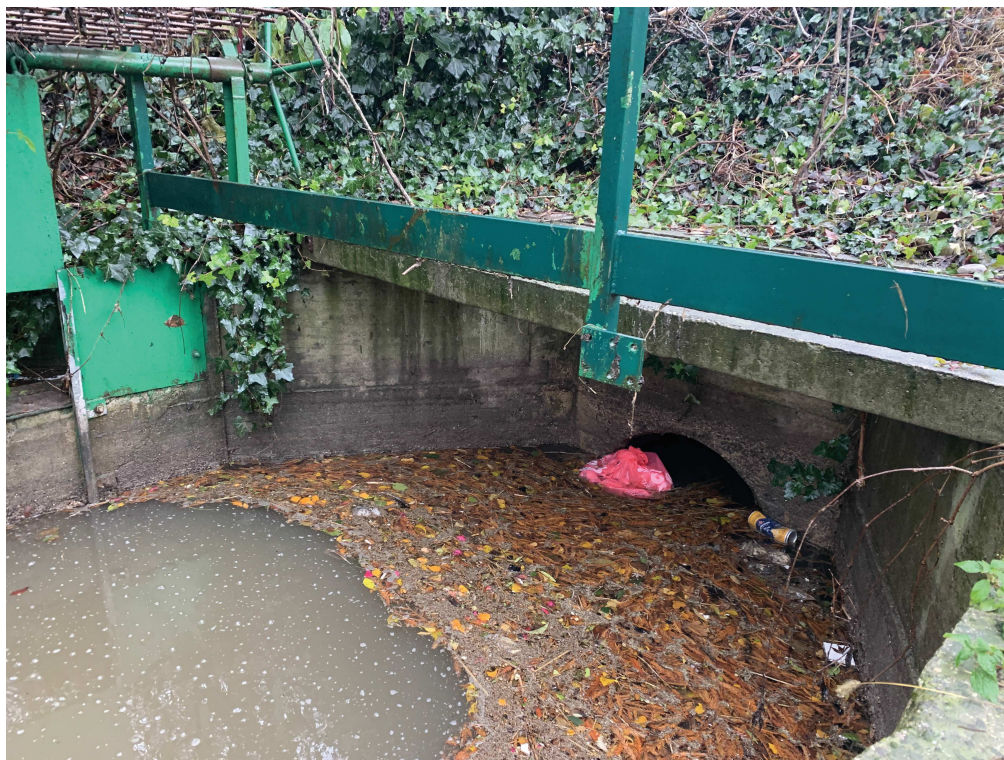
Fig.17-Foto n.3- Manufatto di attraversamento della ferrovia
