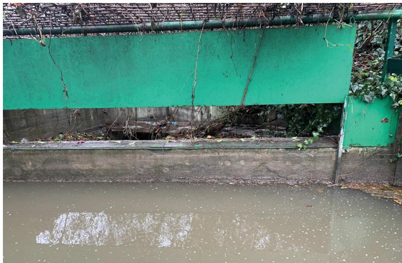
Fig.16-Foto n.2- Scaricatore di piena Comizio 3° e 4° posto a monte del tratto sifonato
