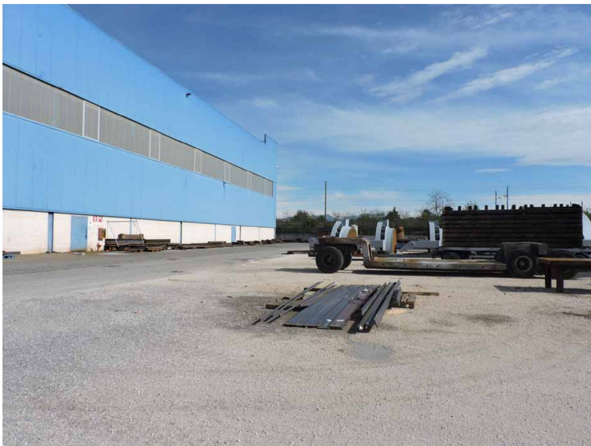
Veduta sull'area oggetto di espansione con SUAP
