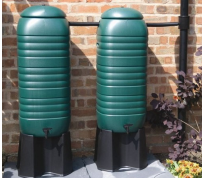
Esempio di contenitori esterni da collegare ai pluviali
