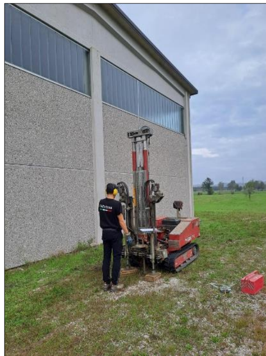
Prova penetrometrica SCPT – P2
