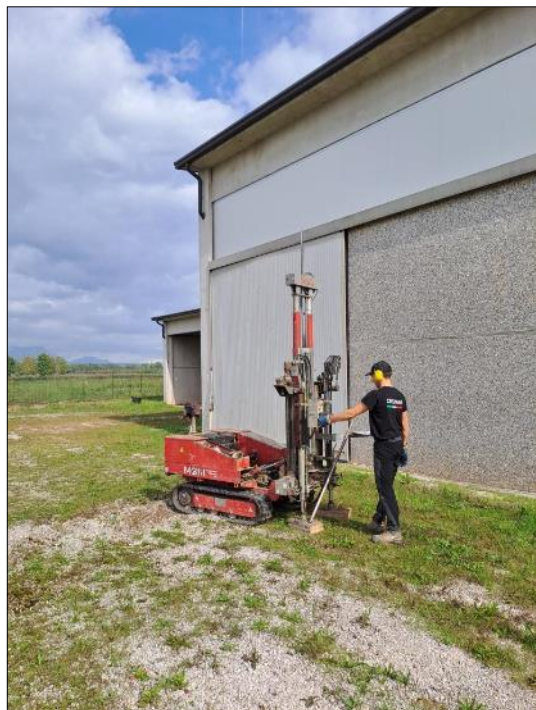
Prova penetrometrica SCPT – P1
