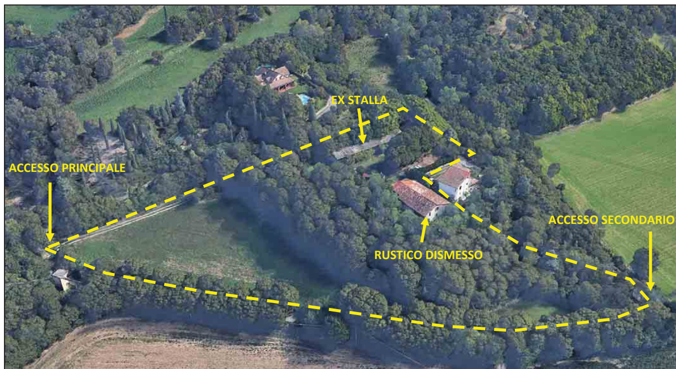
Ortofoto – individuazione perimetro di intervento – vista da ovest verso est
