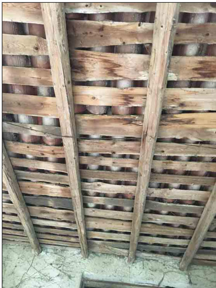
Tettoia on legno e coppi
