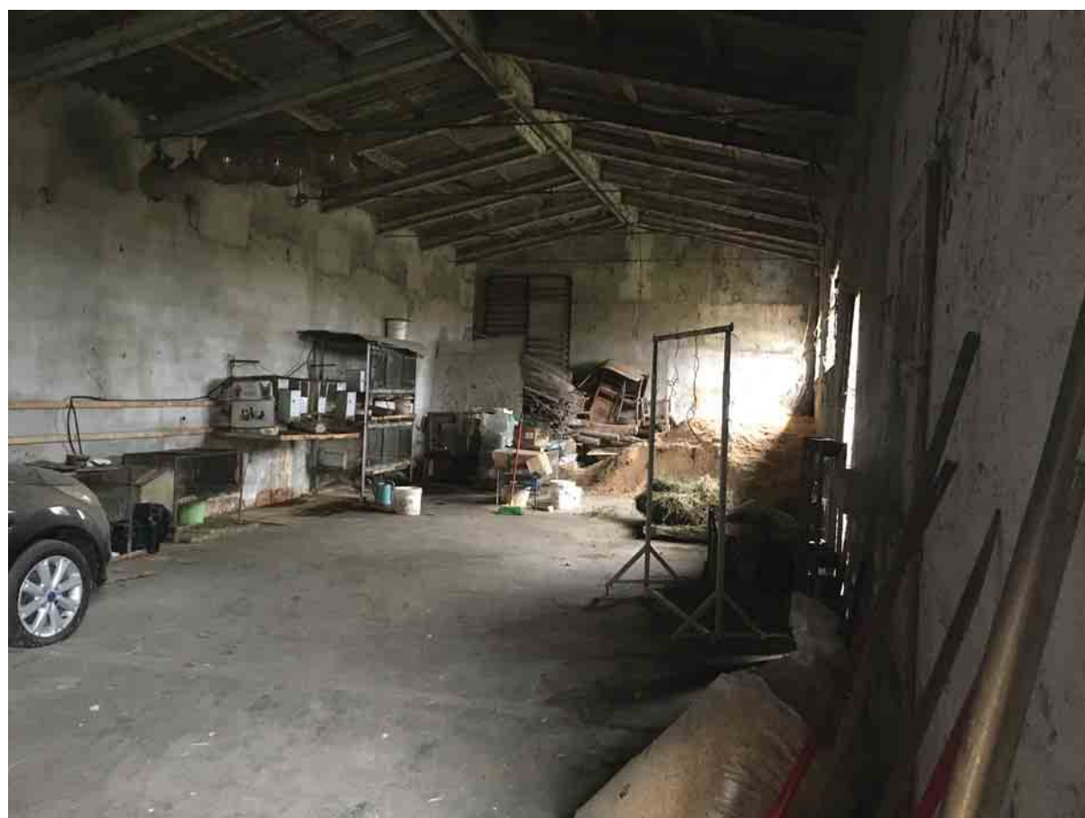
Vista interna dell'edificio ex stalla
