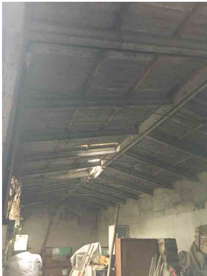
Vista interna dell'edificio ex stalla
