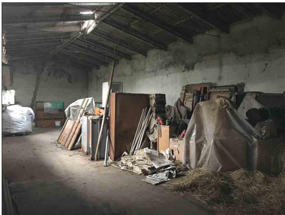
Vista interna dell'edificio ex stalla
