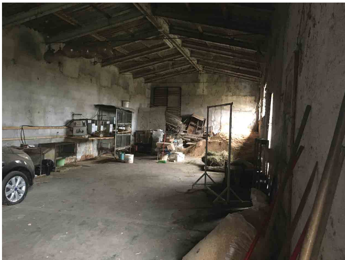
Vista interna dell'edificio ex stalla
