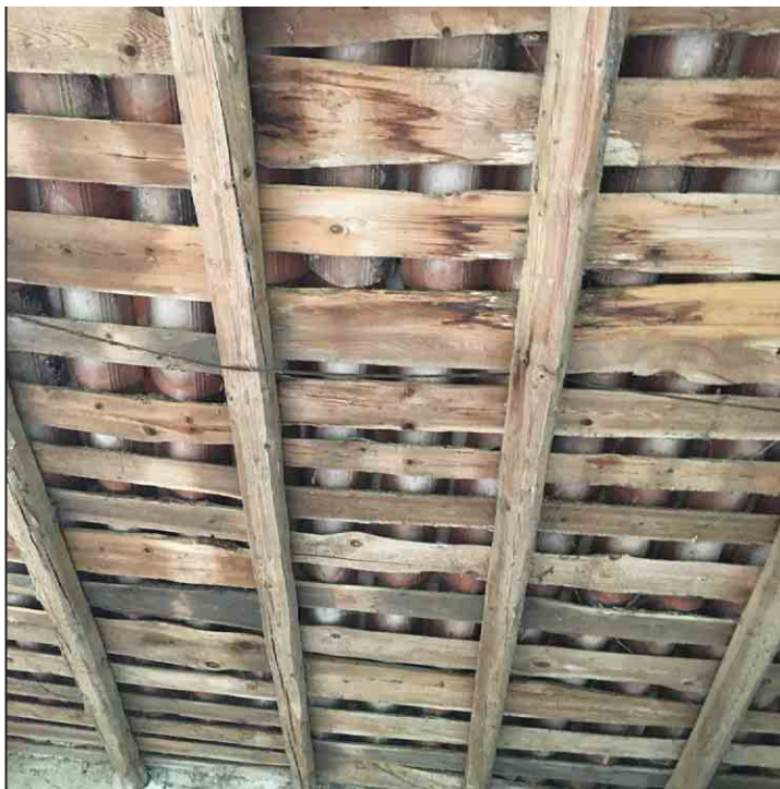
Tettoia on legno e coppi
