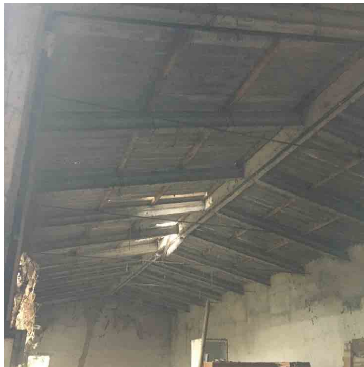
Vista interna dell'edificio ex stalla
