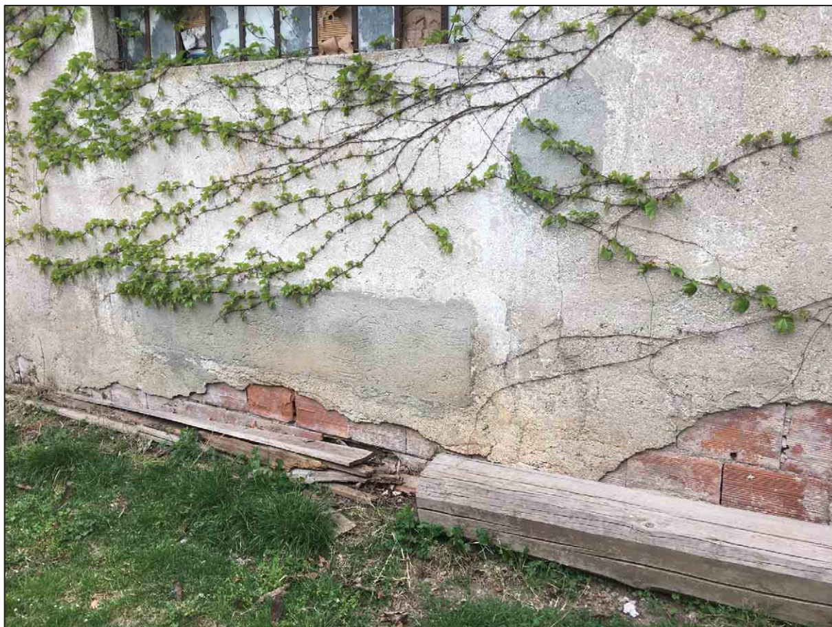
Particolare dell'edificio principale – Foratoni a una testa intonacati
