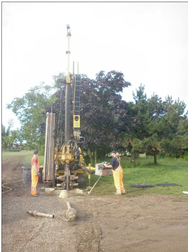
POSTAZIONE SONDAGGIO S1
