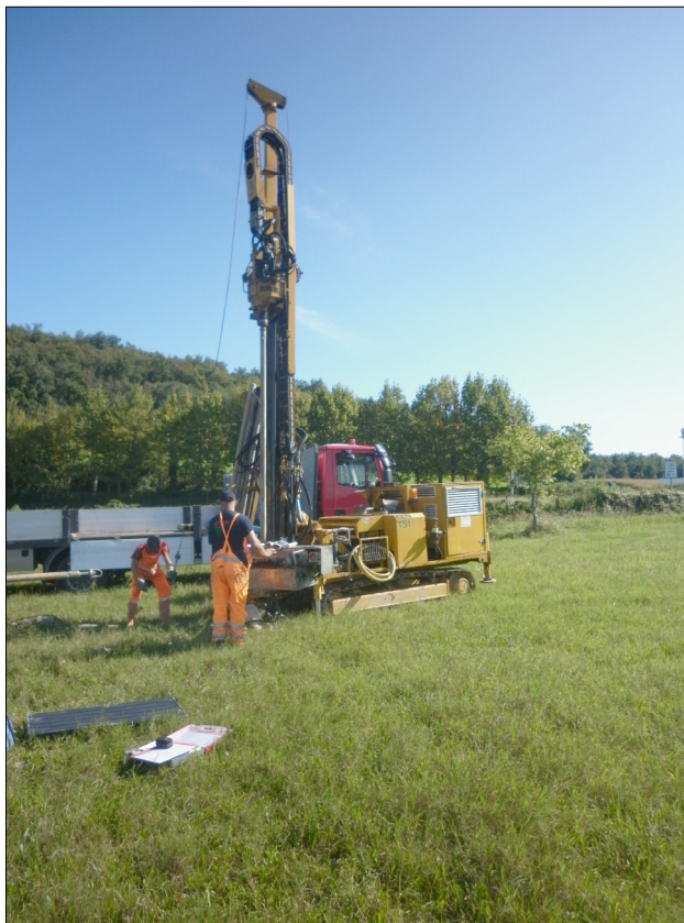
POSTAZIONE SONDAGGIO S2
