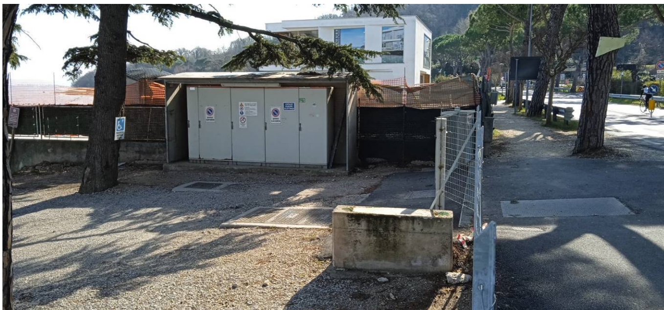
STATO DI FATTO. Zona ingresso
