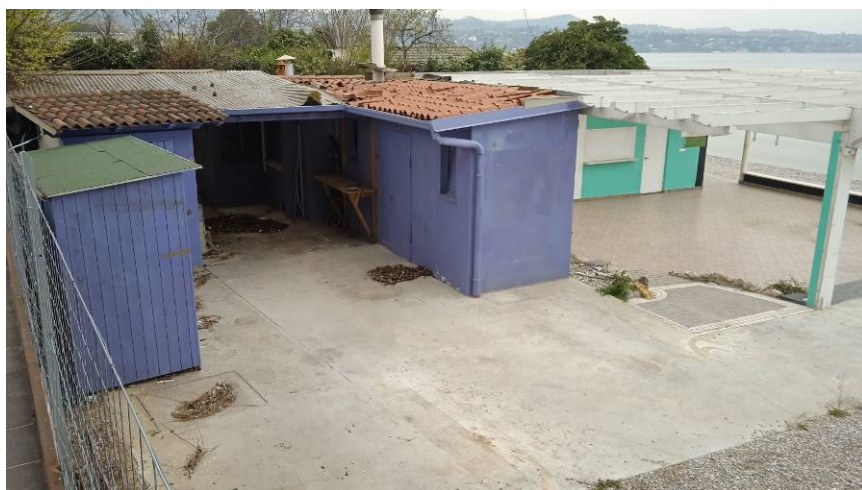
Vista fotografica dalla strada. Dettaglio della struttura oggetto d'intervento.
