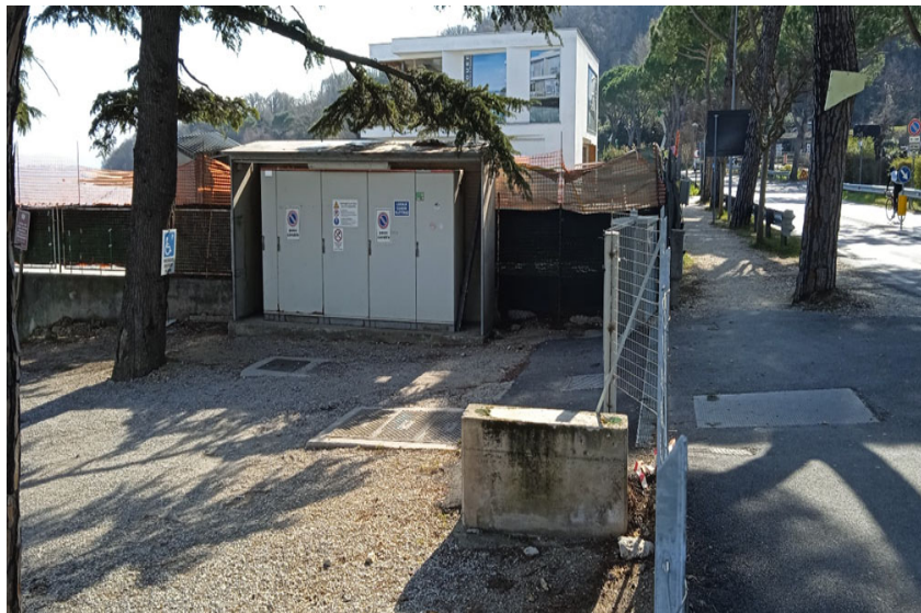
Ingresso all'area oggetto di intervento.
