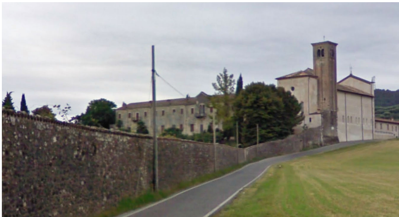
Stato di fatto. Vista del complesso di Maguzzano.
