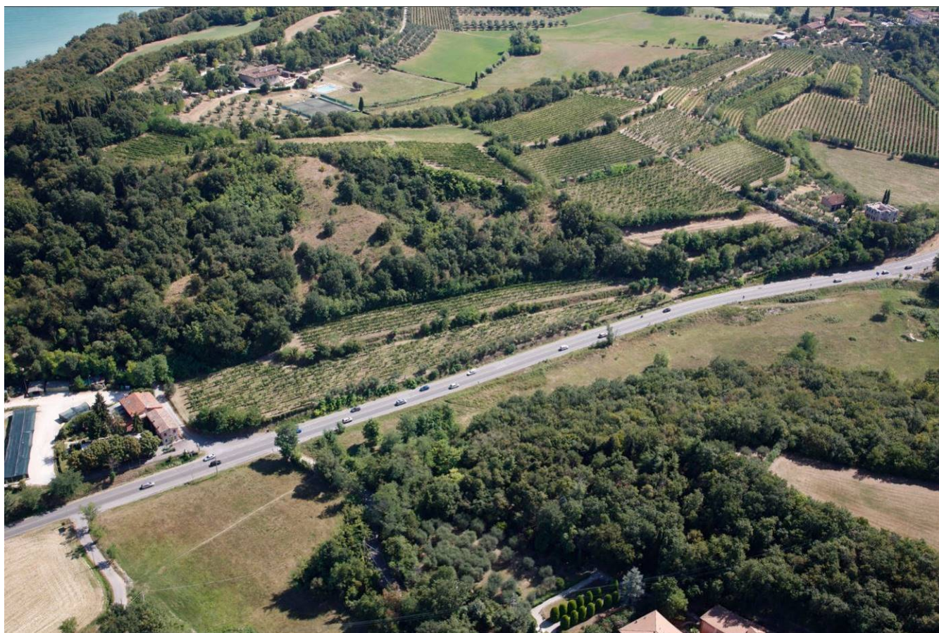
Vista del Monte Corno lato sud est.
