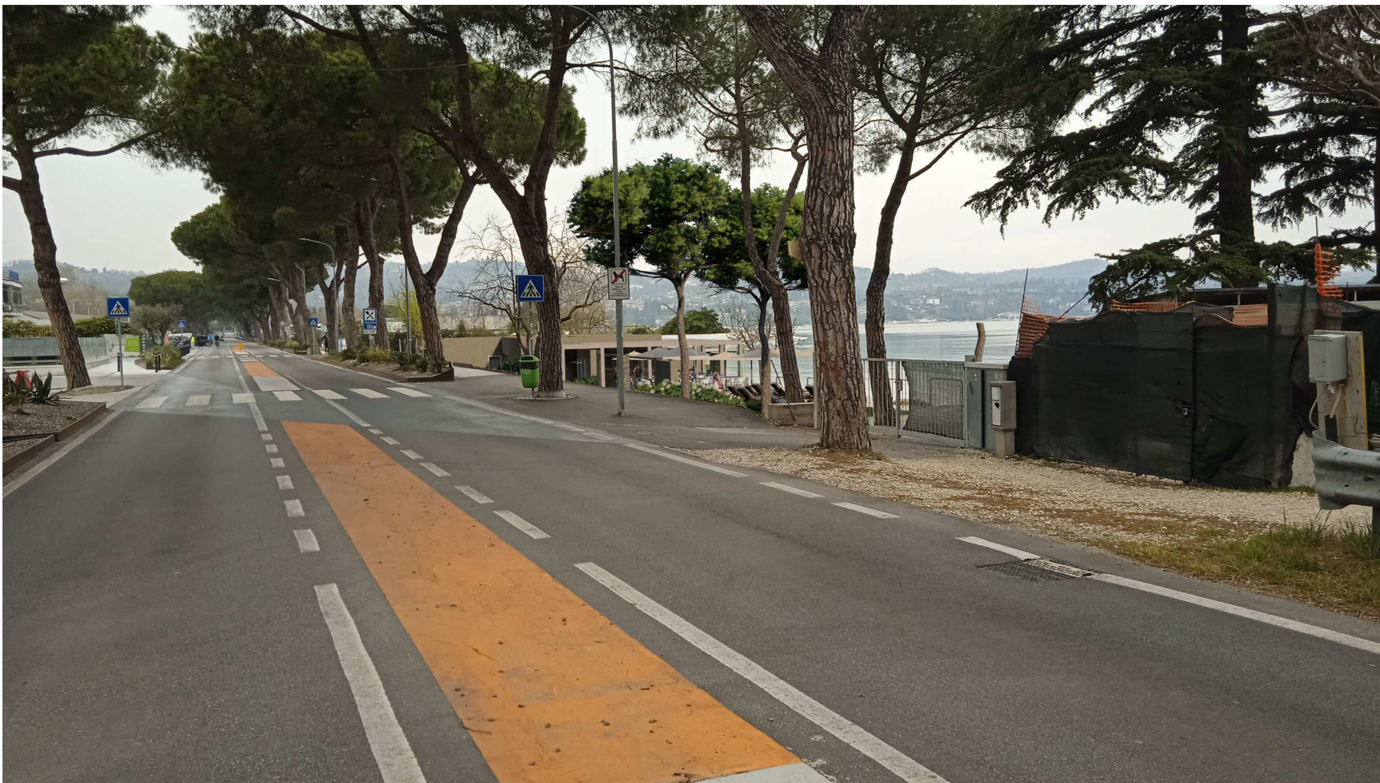
PROGETTO. VISTA 1. Direzione Lonato
