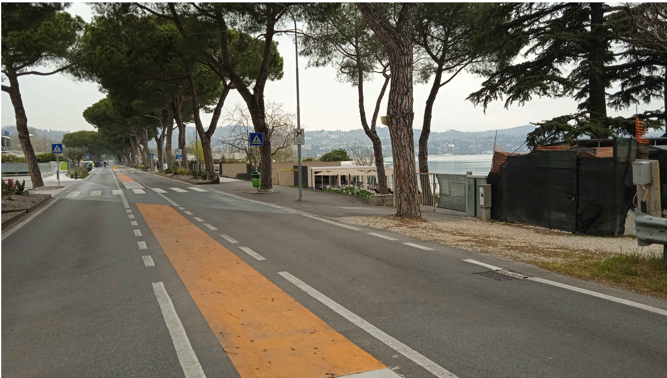
PROGETTO. VISTA 1. Direzione Lonato
