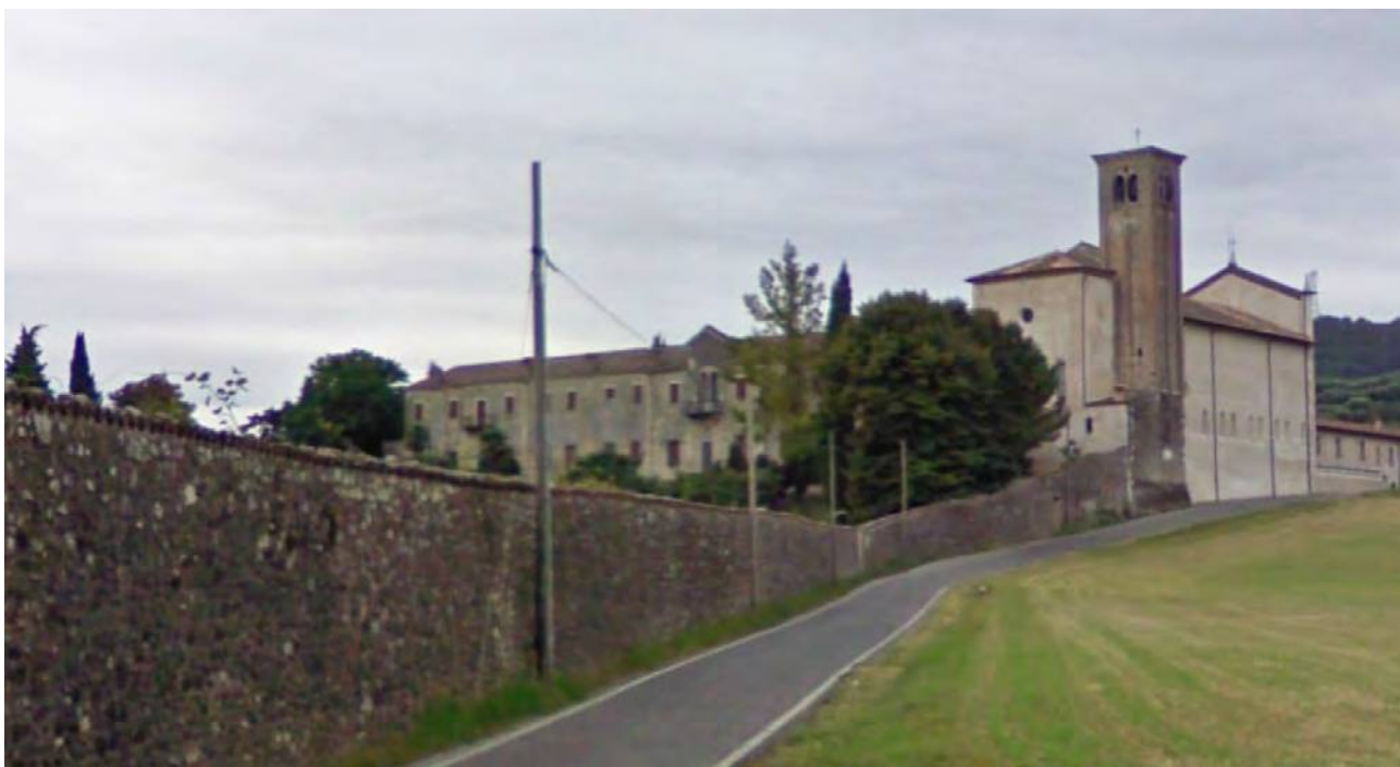
Figura 56. Stato di fatto. Vista del complesso di Maguzzano.
