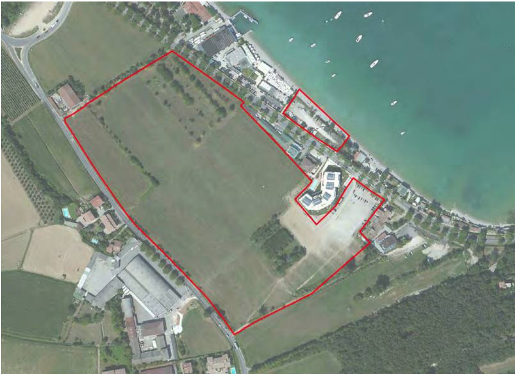
Figura 4. Vista dell'area d'intervento.
