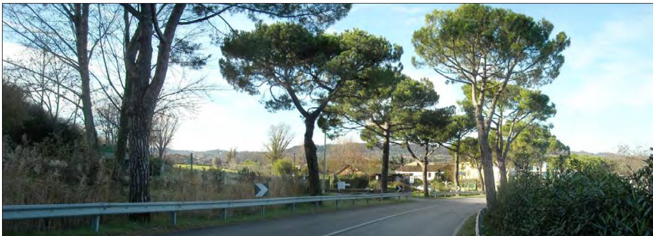
Figura 66. Stato di fatto. Via Catullo nei pressi del complesso "Hotel Bristol". Via Catullo è una strada panoramica che costeggia il lago.
