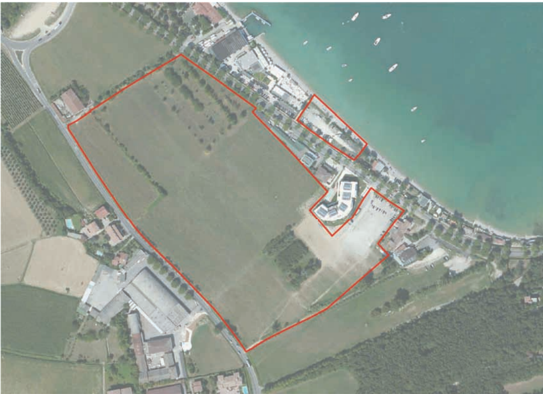
Figura 4. Vista dell'area d'intervento.
