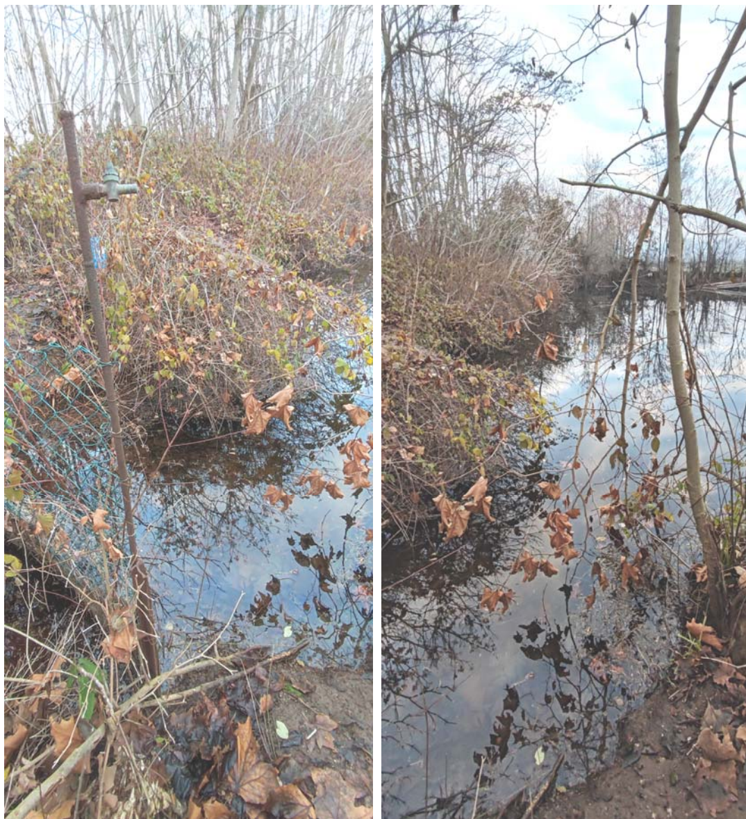
Punto di presa (a N) del Laghetto cod. RIM L9402 "Fossa Fornace dei Gorghi" - EVIDENTE STATO DI DEGRADO PER SCARSA MANUTENZIONE/PULIZIA
