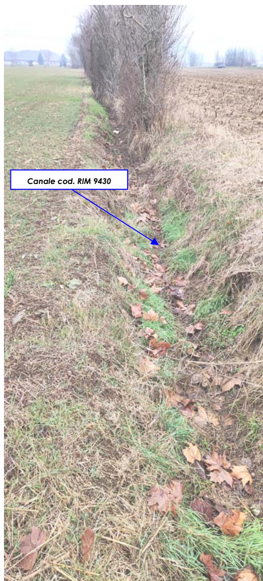
Canale di interesse nel tratto mediano
