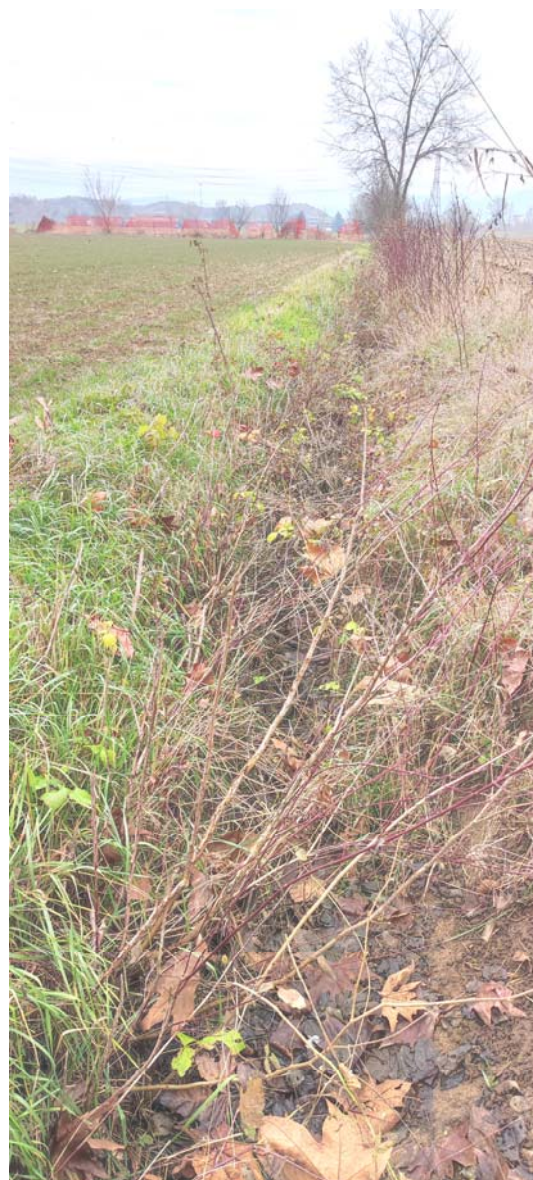
Canale di interesse nel tratto terminale a S
