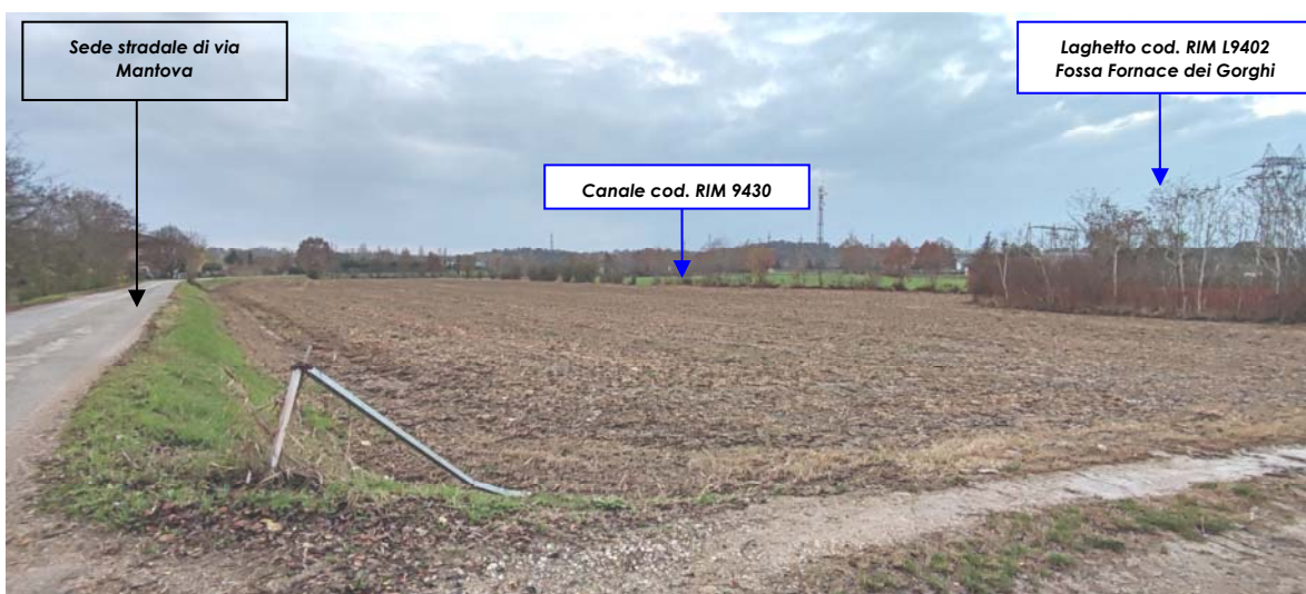
Panoramica di inquadramento generale dell'area – settore NORD (vista da NE)
