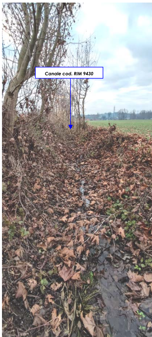
Punto di uscita (a S) delle acque del Laghetto cod. RIM L9402 “Fossa Fornace dei Gorgi” – EVIDENTE STATO DI SCARSA MANUTENZIONE DEL CANALE – MATERIALE VEGETALE IN ALVEO E SULLE SPONDE
