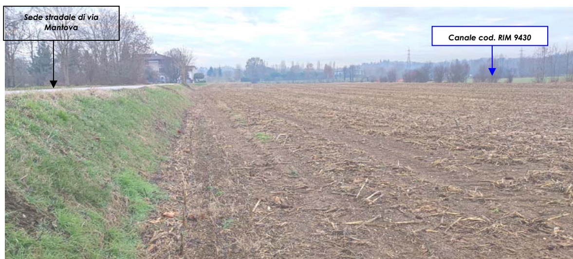
Scarpata E del sito – altezze crescenti procedendo da N a S (1,00-1,80 m)
