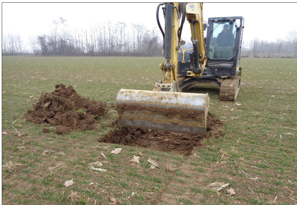
Figura 9. Operazioni di scavo mediante mezzo meccanico
